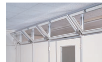
SL 換気のできる内倒しランマ
