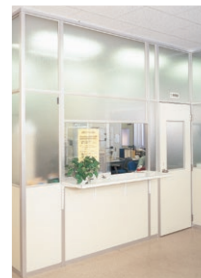
PL ガラスとの組み合わせで明るく開放的な受付カウンター
